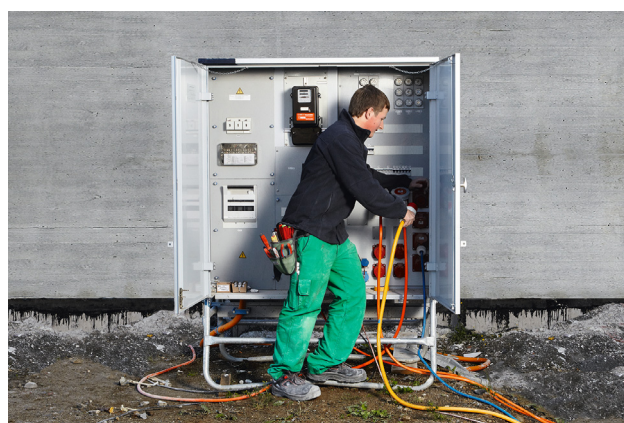
1 Monteur électricien installant un raccordement provisoire.
