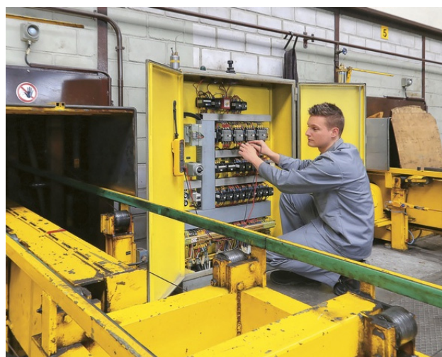
2 Dépannage dans l'armoire de commande d'une machine.
